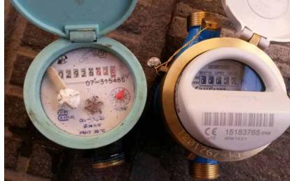
Contatore con modulo trasmissione in frequenza 868 mhz in modalità WALK-BY
