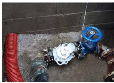
Contatore con trasmissione dati a impulsi
