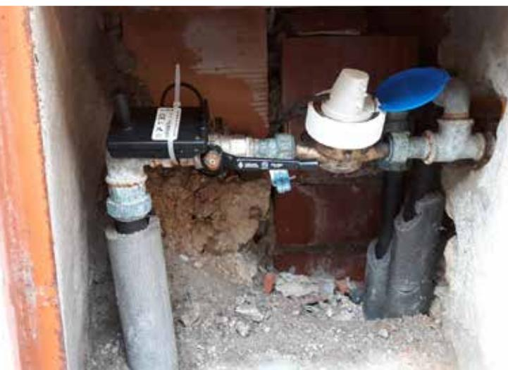
*Contatore con modulo trasmissione in frequenza 868 mhz in modalità WALK-BY*
