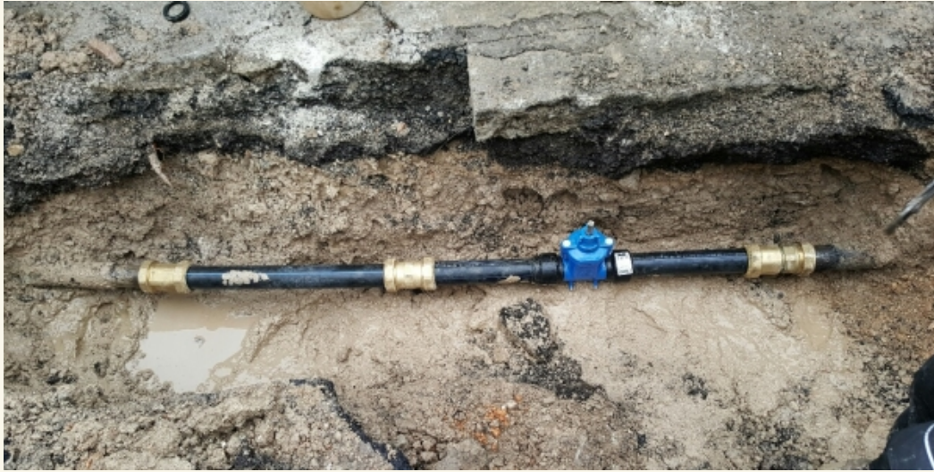
Sostituzione tratto di tubazione
