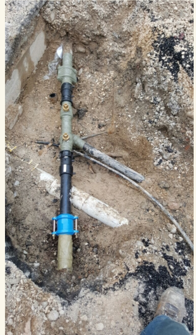
Riparazione tratto di tubazione
