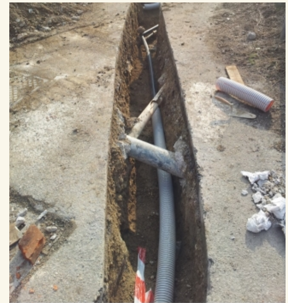
Posa condotta in polietilene
