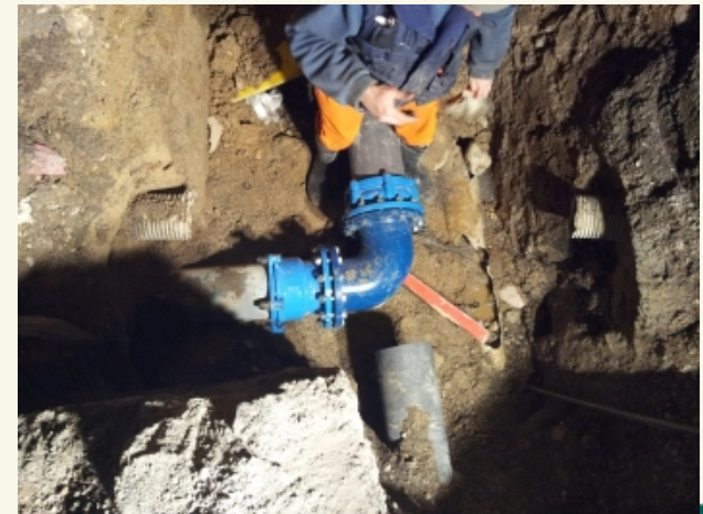
Particolare inserimento curva
