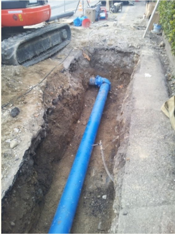
Posa condotta in ghisa
