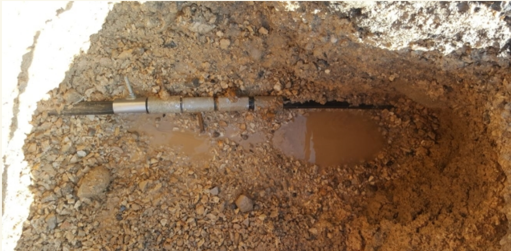
Riparazione tubo polietilene
