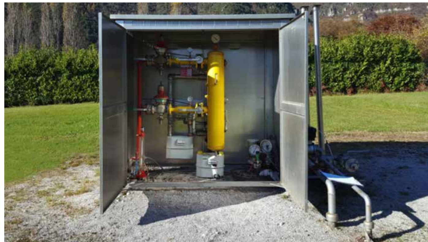
Cabina di prelievo e riduzione dello stoccaggio da 25 mc della frazione Vesio di Tremosine del Garda
